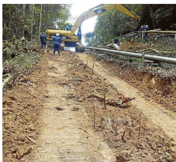
Suministrada/VANGUARDIA LIBERAL Los trabajos de mantenimiento del gasoducto Lisama - El Centro se adelantaron conforme al cronograma que se trazó Ecopetrol.
